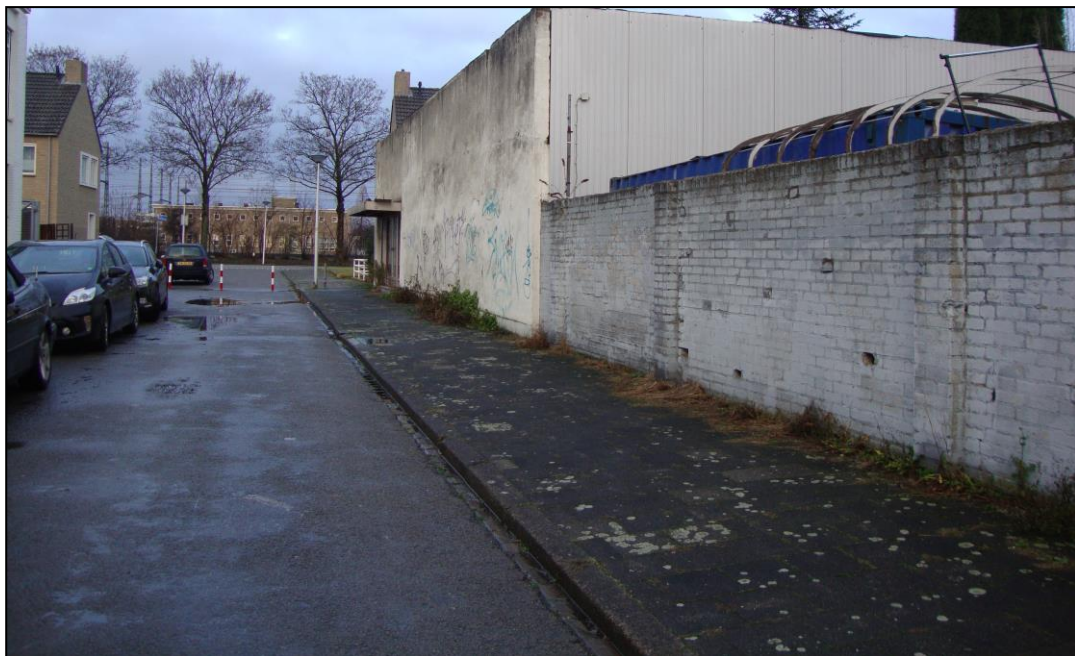
De leegstaande bedrijfsloods aan de Kasteel Holtmeulenstraat 10
